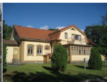
Anttilan kantatalon entinen päärakennus, joka toimi lääkärintalona. Julkisivu länteen.
